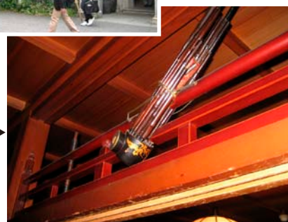
水琴亭の欄間▶
